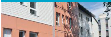
RÉSIDENTE «CAMPUS CENTRE- VILLE» RAMBOUILLET
